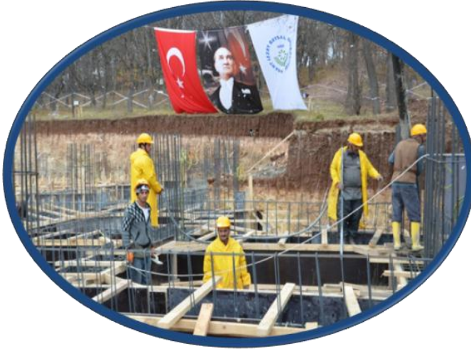
Spor Salonu Ek Bina temeli atılmıştır.
